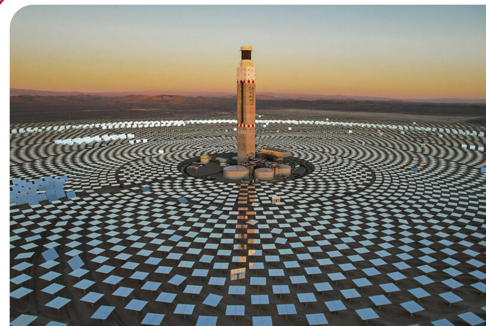
Champ d'héliostats solaires à Cerro Dominador au Chili (450 Mwatts) (source : www.solarpaces.org)
